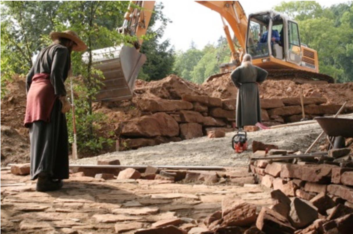
pflasterten wir ein paar Meter mit den frisch gesammelten Steinen; die ganz großen Brocken wurden mit Hilfe des Baggers zu einer schönen Trockenmauer aufgeschichtet. Zuletzt kam, wieder unter ständigem Nivellieren, der Feinschliff, und Vater Symeon befestigte schließlich den Schotter mit der schweren Rüttelmaschine.
