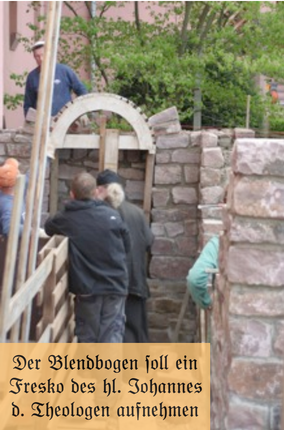
Mit Spaltplatten lassen sich Rundbögen viel schneller und einfacher mauern; sie setzen sich dann mehr ab und bilden ein eigenes Zierelement – ein Hauch von Byzanz.
