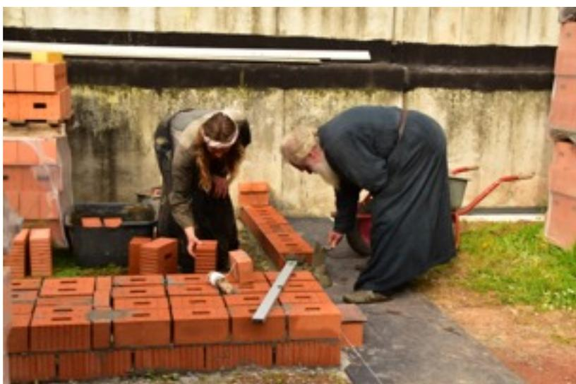
So lernten Hörche und Helfer von Vtr. Abt und Vtr. Symeon das rechte Mischen des Mörtels, das Mauern und nicht zuletzt das Reinigen der Werkzeuge nach Arbeitsluß. Die Ecksteine zum Spannen der Maurer-schnüre legte V. Symeon an. Er führt auch die Maurerarbeiten mit Sandsteinen durch. Die
